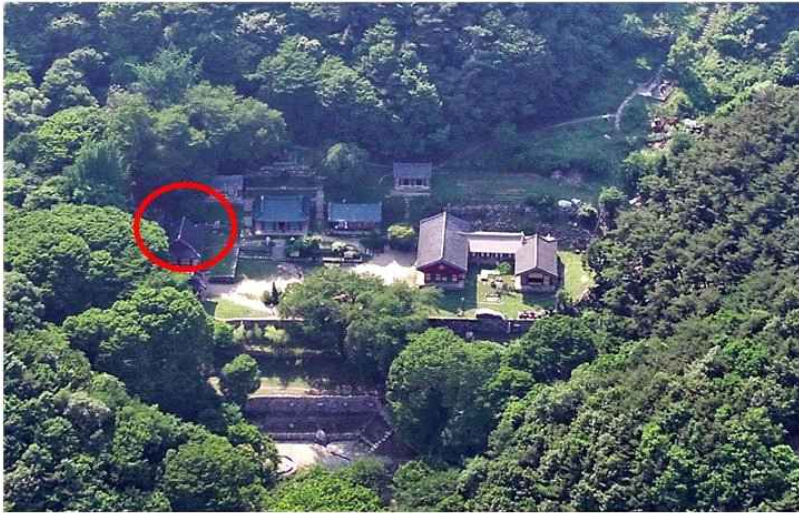
완주 대원사 전경(명부전에 목조지장보살삼존상, 시왕상이 안치되어 있음. 복장유물은 별도 보관중)
